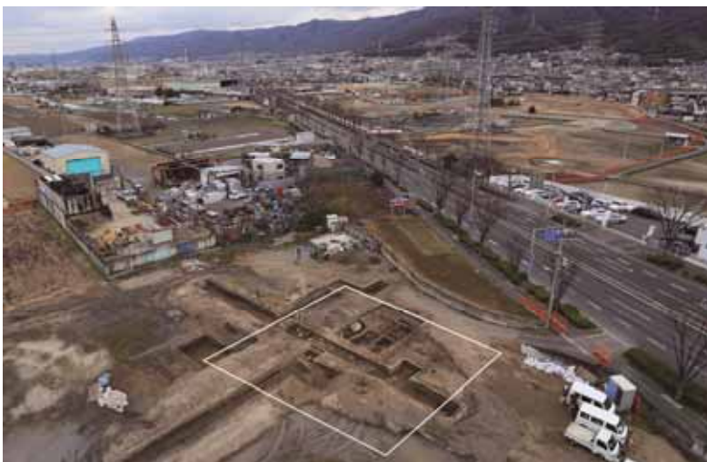
写真8 由義寺跡 塔基壇検出状況(南西から・奈良時代後期)
