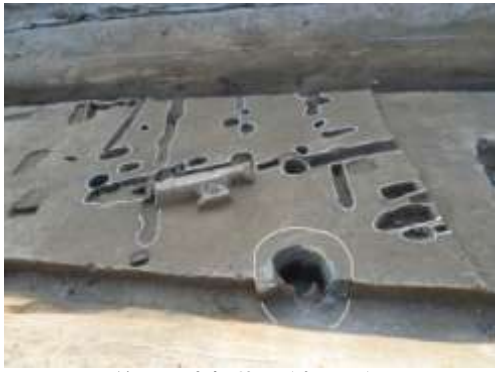
第2面完掘状況(東から)
