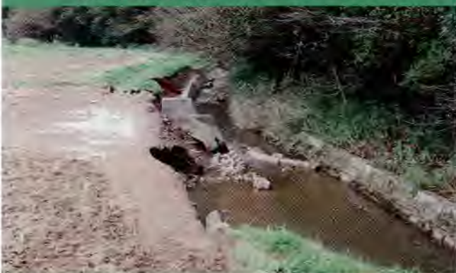
黒沢幹線排水路（改良区事業主体）
