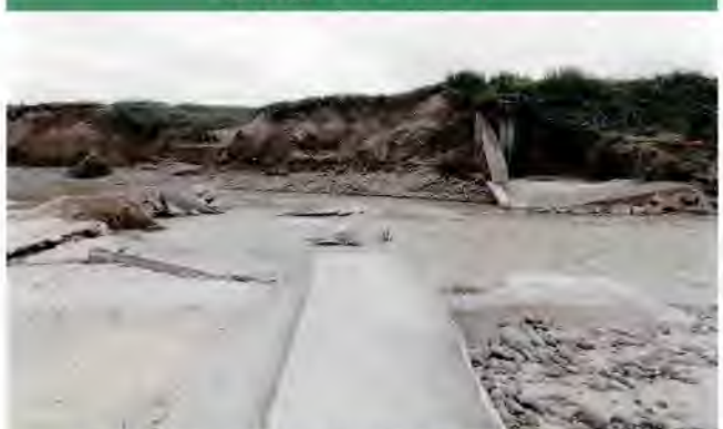
明神堰（県事業主体）
