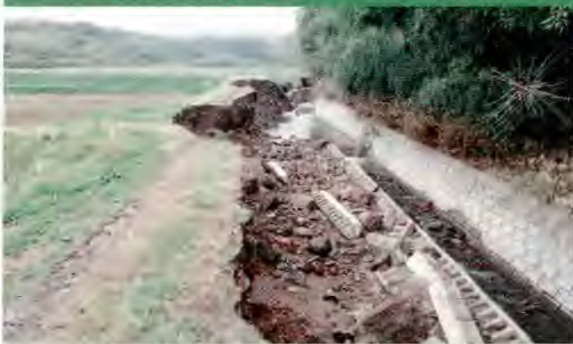
蛭沢幹線排水路（改良区事業主体）
