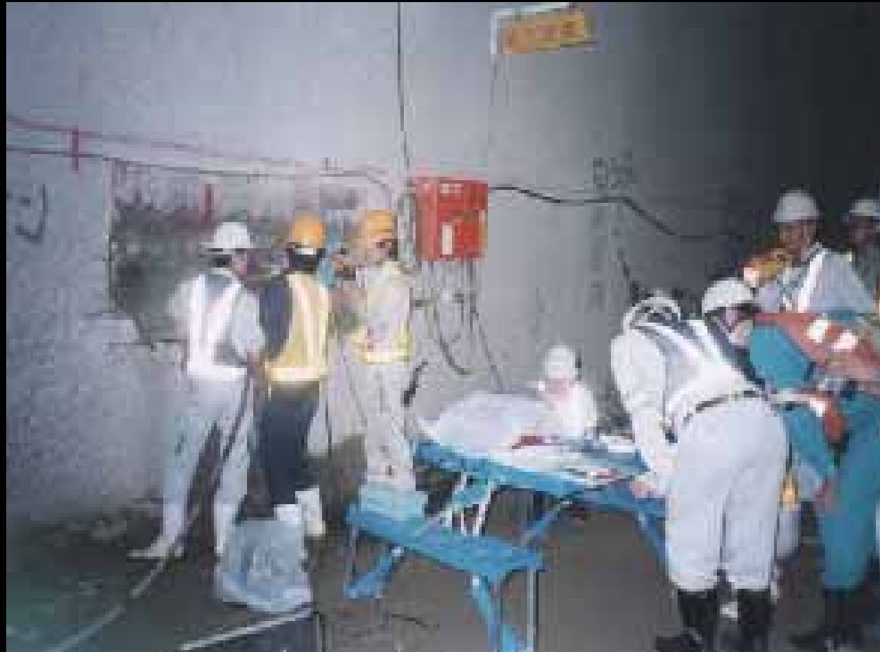
コアリング中の現場風景
