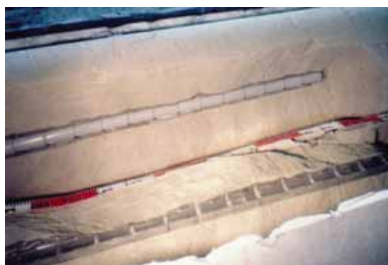
写真 1 くさび方式のアンカー体解体状況
