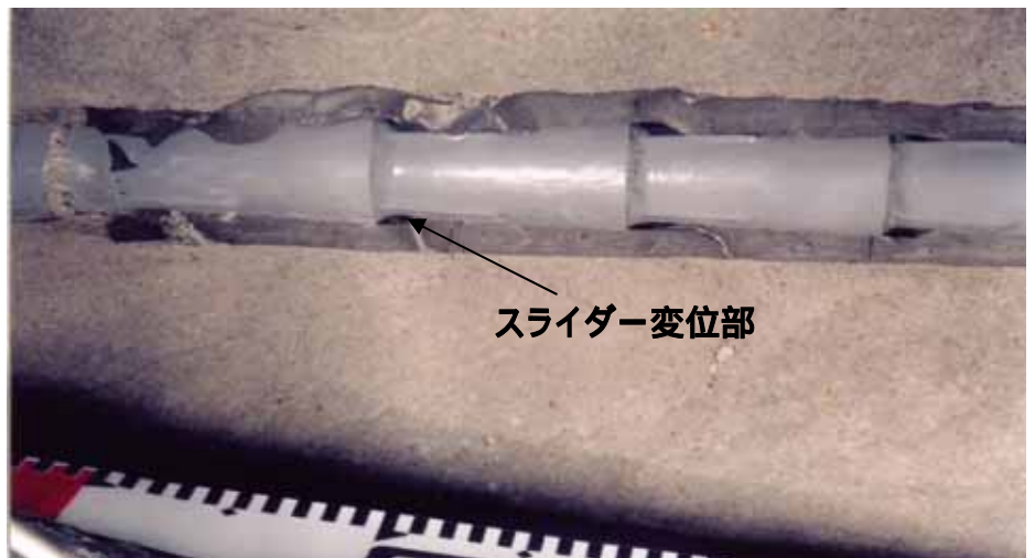
くさび変位状況(変位することにより径が拡大し側圧が生じる)
