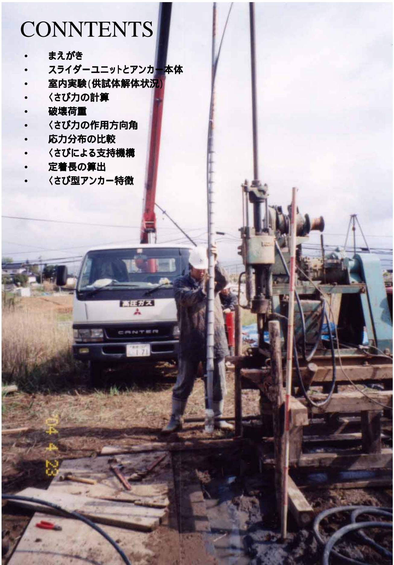
くさび型アンカー設置
