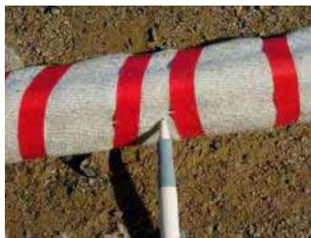
写真 5.7 ビニールテープの切れ目加工
