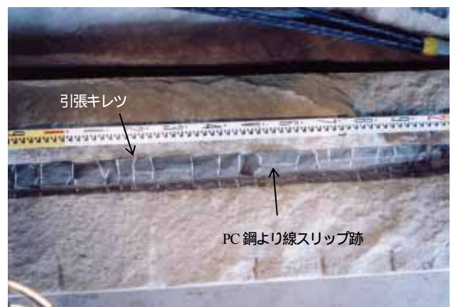
写真 3.8 摩擦 (引張) 型アンカー体 (荷重 1,000kN)
