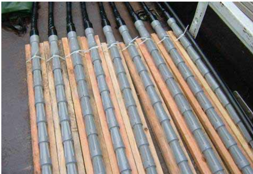
写真 3.2 アンカー体拘束具組立て状況 (300Ws 型)
