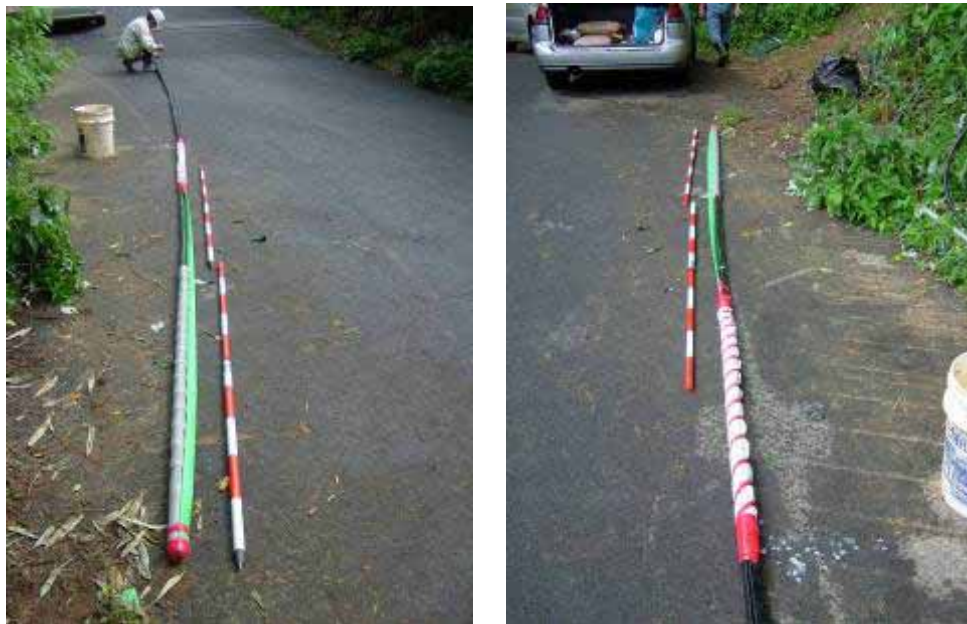
写真 5.1 パッカー取り付け状況（300Ws 型アンカー） スライダー部分のグラウトホースは扁平ホース （ネオデリコンφ19mm）仕様
