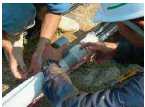
写真 5.6 テープによる固定
