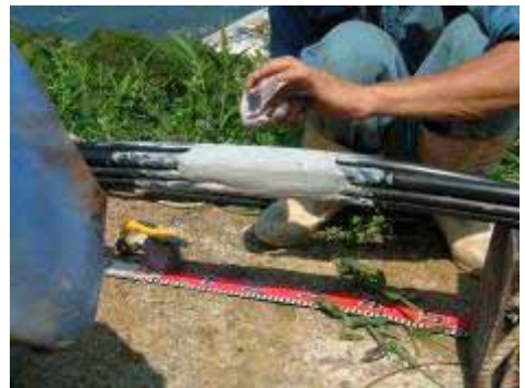
写真 5.4 止水ボンド充填
