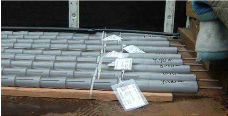
写真 3.3 アンカー体拘束具先端固定金具 (300Ws 型)
