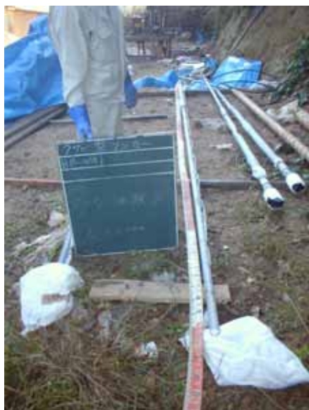
写真 2.21 アンカー体検尺
