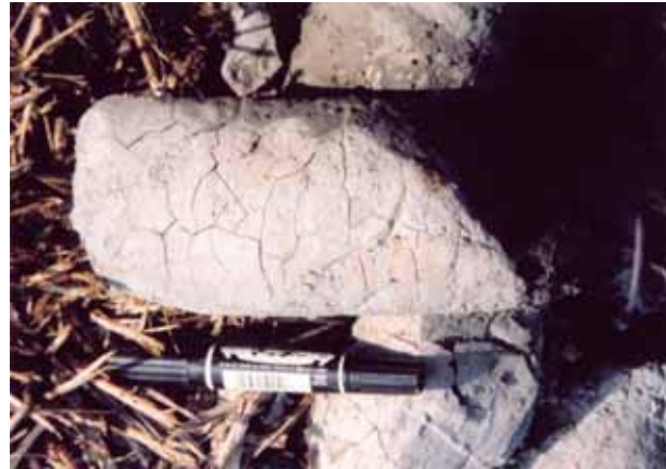
写真 2.18 定着地盤の泥岩 (掘削 2 日後のスレーキング状況)
