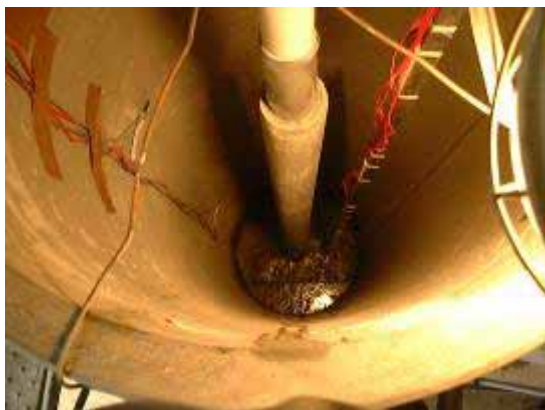
写真 2.1 アンカー体と歪み計設置状況
