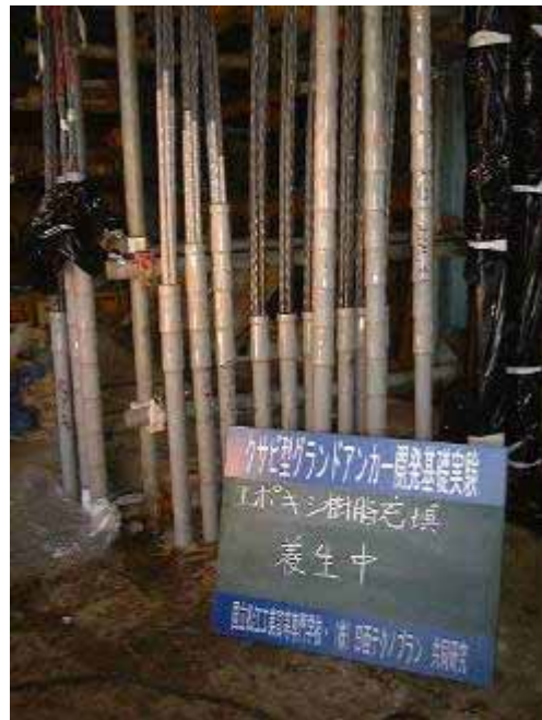
写真 2.10 拘束具内に引張材を挿入し、エポキシ樹脂で固定
