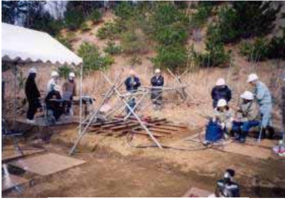
写真 2.15 引抜き試験状況
