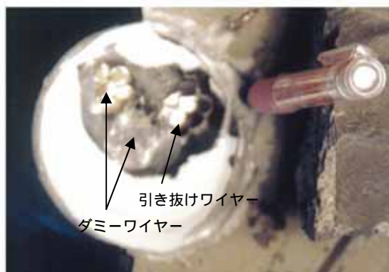
写真5 Strand先端の引抜け状況
