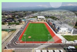
立山中央小学校 人工芝 iDNA-60 施工
