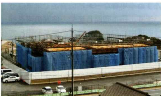
建築中の隊舎
