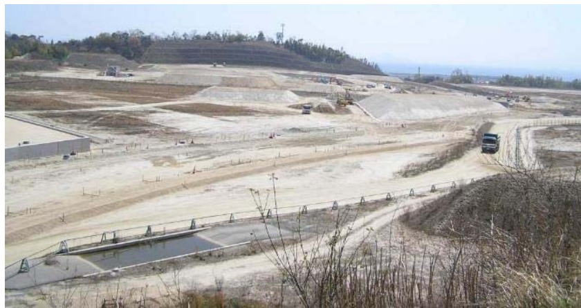
造成工事が進む愛宕山跡地(2011.4.15 田村順玄・岩国市議が撮影)
