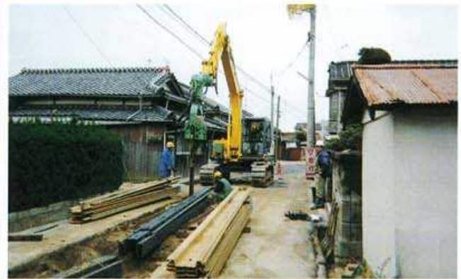
PALSONIC-4B 山口県防府市役所下水道課/公共下水道築造工事 軽量鋼矢板Ⅲ型-4m ベースマシン:0.35㎡ 土質:シルト N値:5
