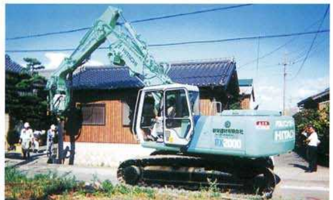
PALSONIC-10D 三重県川越町役場下水道課/下水面整備工事 軽量鋼矢板Ⅲ型-3m ベースマシン:RX2000 土質:砂 N値:4
