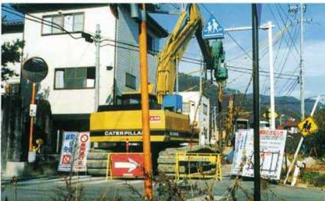
PALSONIC-7B 長野県川中島水道管理事務所/長野地区送水幹線布設工事 鋼矢板Ⅱ型-6m ベースマシン:0.7㎡ 土質:砂 N値:15
